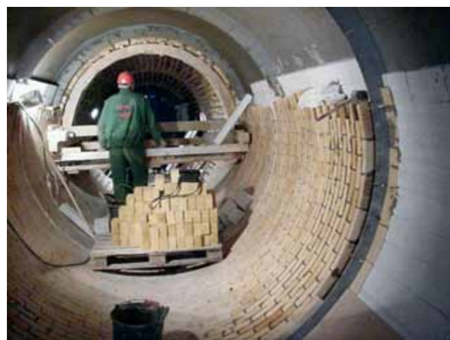
Процесс кладки кирпичей Vjuf SX в третичном воздуховоде
