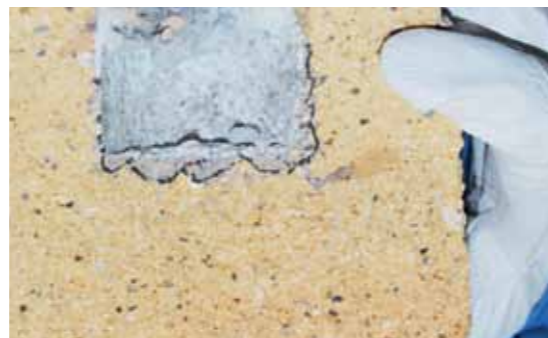
Для измерения проникновения щелочных соединений выполняются регулярные испытания. На фото видно, что кирпич Vjuf SX показывает чрезвычайно высокую щелочностойкость.
